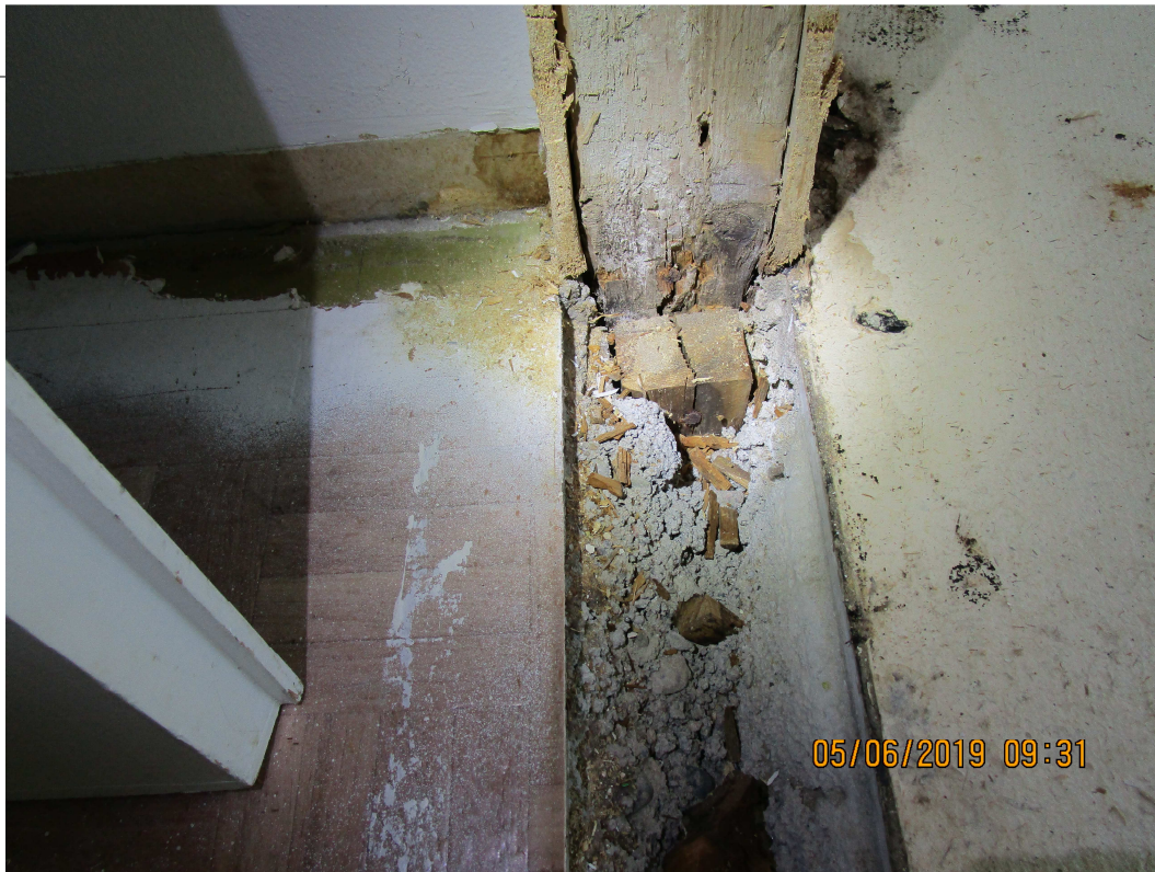
Kuva 3. Kosteusvaurioituneita väliseinärakenteita.
