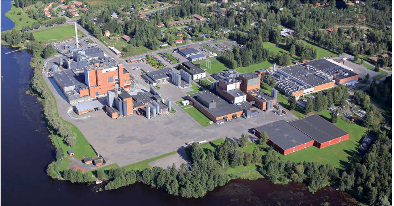
Näkymä etelästä. Tämä on vuonna 2013 otetusta valokuvasta retusoitu ja kuvaa alueen rakennettua tilannetta vuonna 2017. Kuva: RE-suunnittelu Oy
