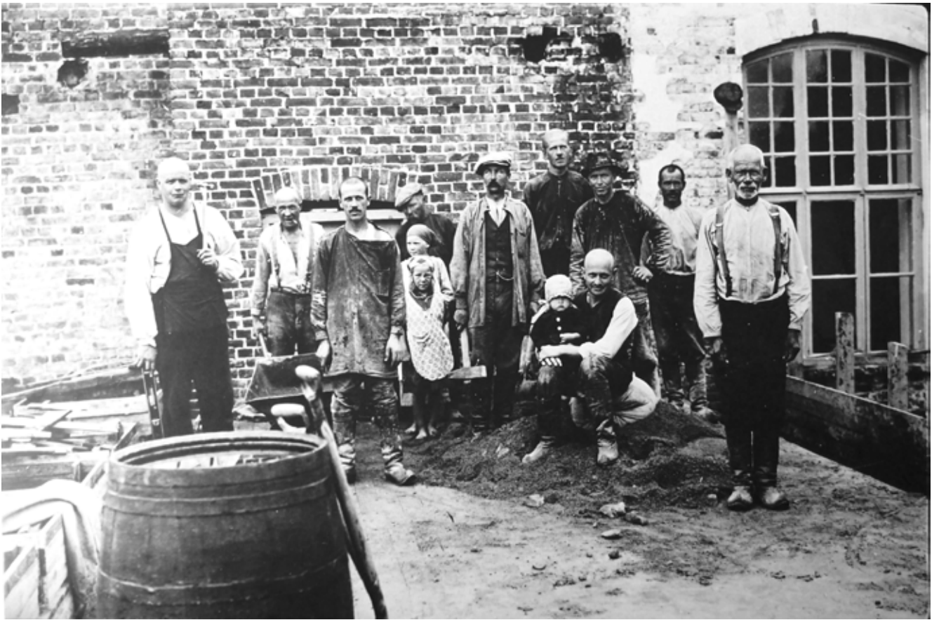
Konttori- ja asuinrakennuksen työmaakuvia vuodelta 1927. Yläkuvassa työmiesten takana näkyy ensimmäisessä vaiheessa valmistuneen meijerin punatiiliseinä. Paikalta purettiin meijerirakennukseen liittynyt puinen osa (ks. kuva edelliseltä aukeamalta ) Oikealla näkyvässä seinäosassa näkyy vaaleaa rappausa. Seinä on rapattu ilmeisesti siinä yhteydessä kun voima-asema rakennettiin ja rapattiin vaaleaksi. LSA
