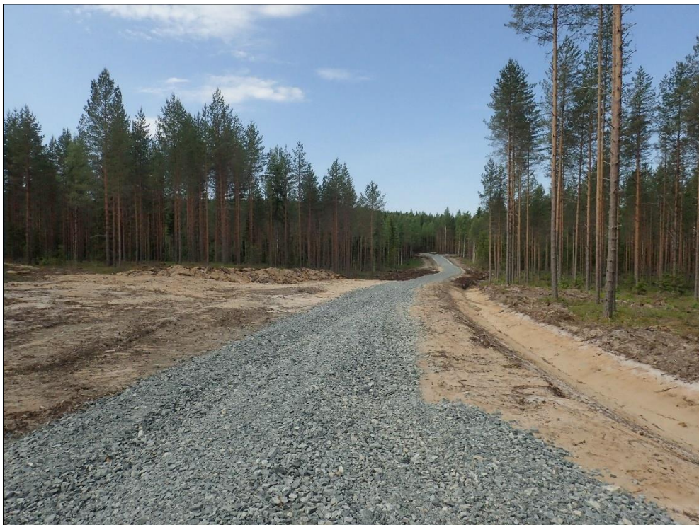
Yleiskuva tutkimusalueen eteläosasta (Raateelanmäen itäpuolelta). Länteen.
